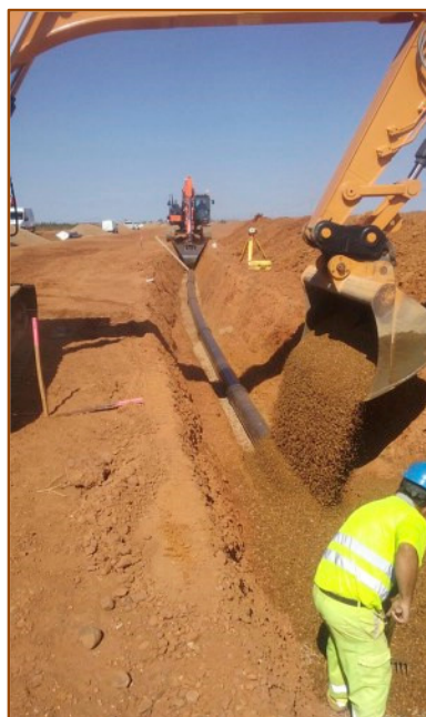
Colocación tubería PVC, estación de bombeo y red de riego de la subzona de Payuelos, zona regable del embalse de Riaño (León)
