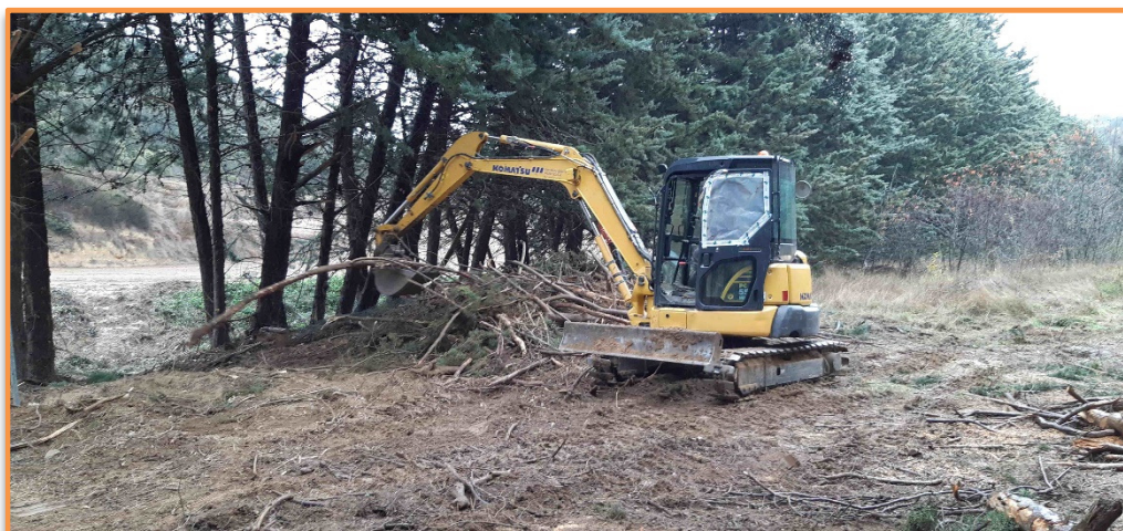
Limpieza de cauces (Zamora)
