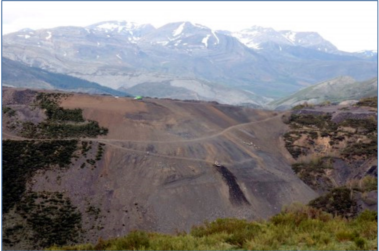
Rehabilitación del espacio natural afectado por la explotación minera a cielo abierto de carbón denominada la Nueva Julia en el término municipal de Cabrillanes. +(León)
